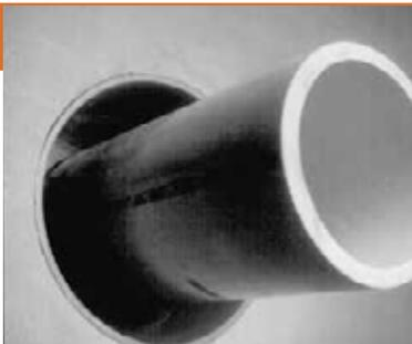
Отцентрируйте трубу в заранее просверленном стеновом отверстии или в гильзе. Убедитесь, что трубопровод имеет опору с обеих сторон. Уплотнительная цепь не должна выдерживать вес трубы.
