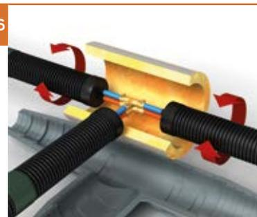
Установите большой сегмент теплоизоляции на основную трубу с помощью самоклеящейся ленты (не входит в комплект). Меньший сегмент изоляции закрепите вокруг отвода трубопровода.
