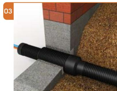
03 Как только термоусадочный рукав остынет, завершите монтаж, заполнив землей пространство вокруг гильзы и трубопровода. После чего можно монтировать соединения напорных труб к внутренним системам в здании.
