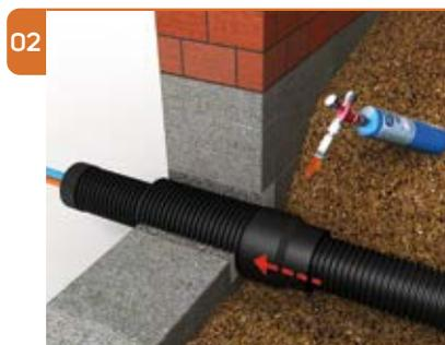
02 Наденьте термоусадочный рукав на гильзу так, чтобы закрыть и гильзу, и кожух трубы. Мягко нагрейте термоусадочный рукав и обожмите его по всей поверхности, используя защитные перчатки.
