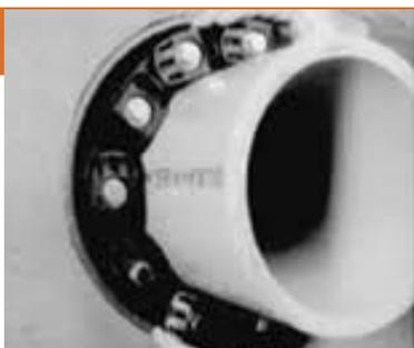
Убедитесь, что прижимные пластины на обратной стороне цепи уплотнения выровнены правильно. После установки в проем в стене они больше не будут доступны. Вставьте уплотнительную цепь в кольцевое пространство. Для цепи с уплотнением большего размера начните вставлять узел цепи в положение на «6 часов» и двигайте обе стороны вверх к положению на «12 часов» в кольцевом пространстве.
