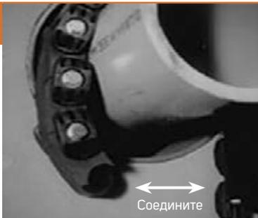
Ослабьте заднюю прижимную пластину с помощью гайки ровно настолько, чтобы звенья двигались свободно друг к другу и друг от друга. Соедините оба конца цепного уплотнения.
